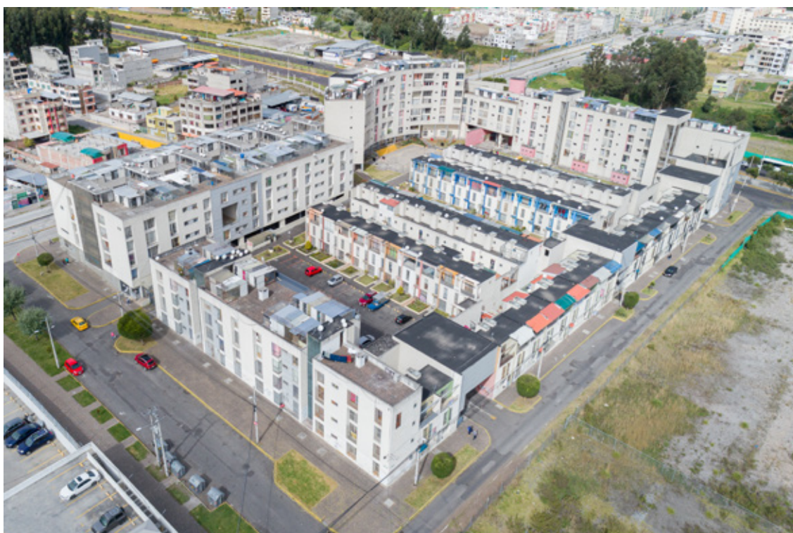
Cumbres de Quitumbe. Vista Aérea desde Quitumbe Ñan. Foto: Santiago de la Torre
