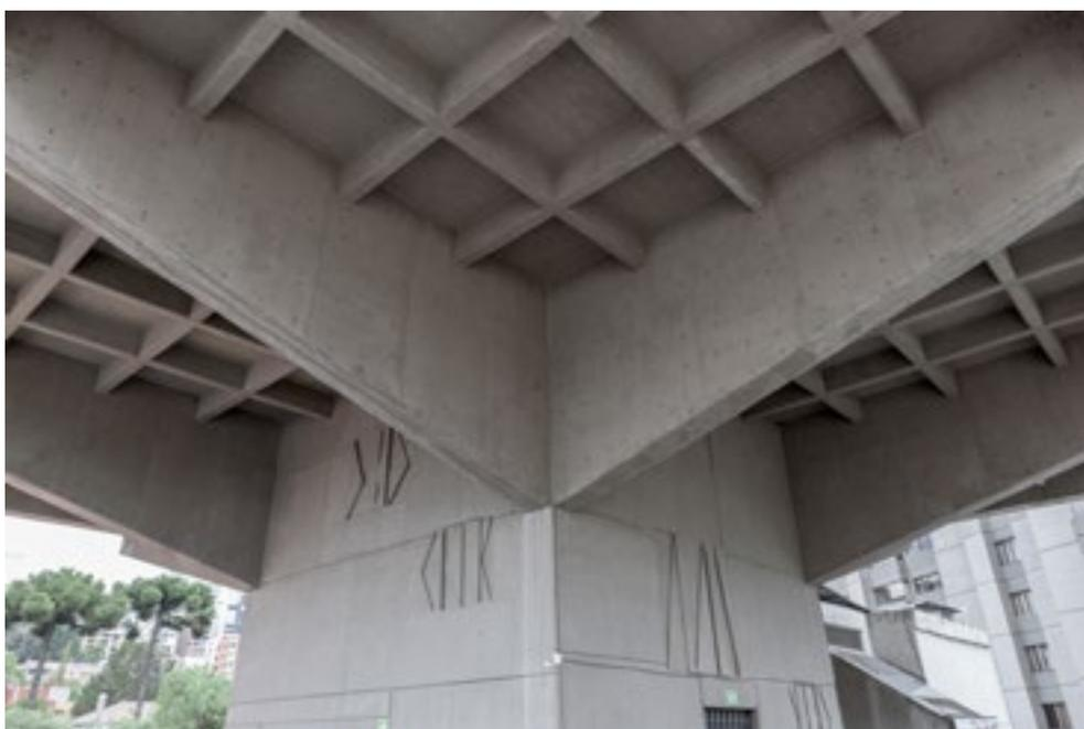
Imagen 3 Detalle de la unión de las vigas que sostienen el volumen superior y el núcleo central de circulaciones, Quito (2021).
