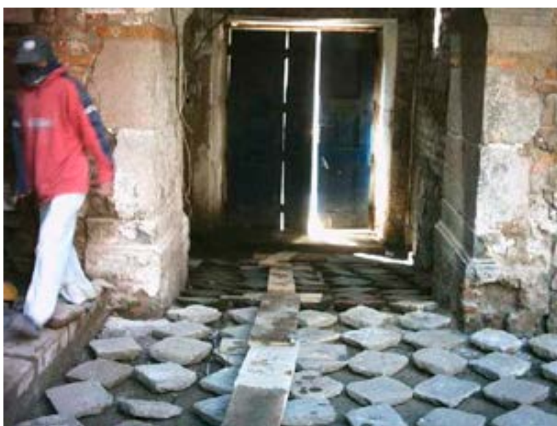
Foto 38. Pisos de adoquín de piedra en galerías. Foto M. Hidrobo, 2005.
