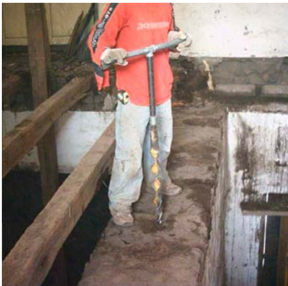
Foto 58. Perforación manual con barrenos para colocar micropilotes verticales. Foto M. Hidrobo, 2005
