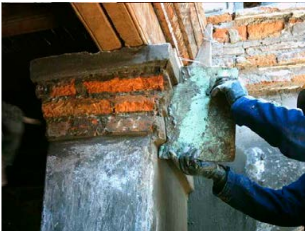
Foto 67. Ejecución de molduras en arcos de mampostería, patio 1. Foto M. Hidrobo, 2005
