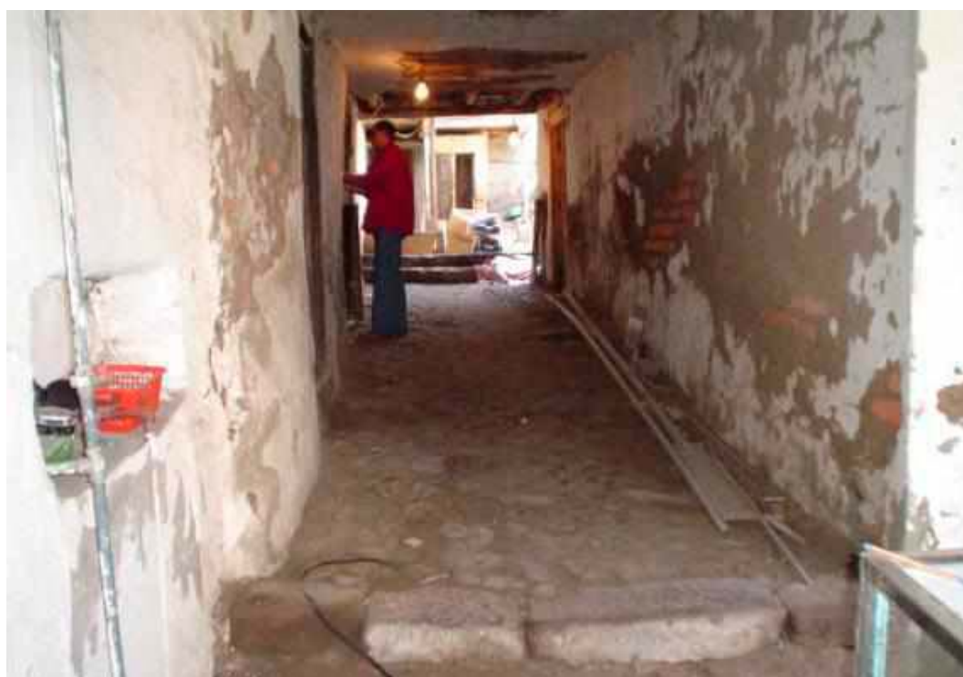
Foto 20. Labores de levantamiento. Vista de pasillo entre patios 1 y 2. Foto M. Hidrobo, 2003
