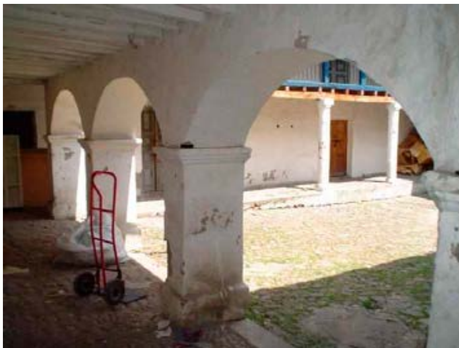
Foto 17. Vista de galería de arcos en patio 1. Foto M. Hidrobo, 2003
