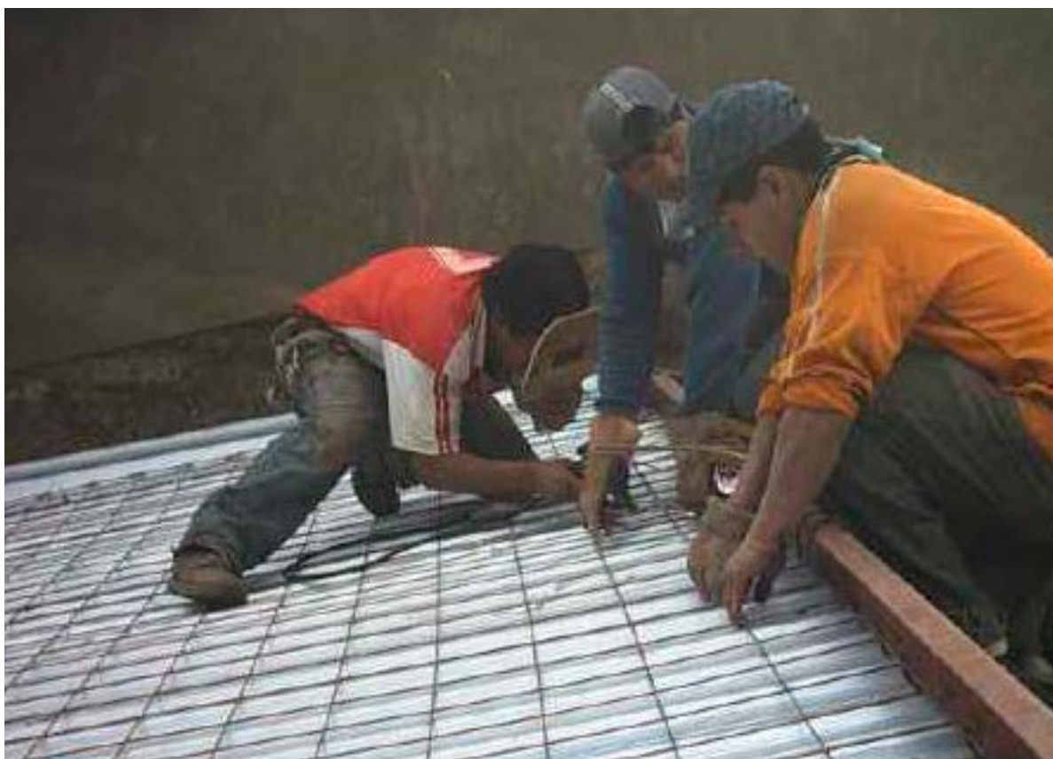
Foto 80. Colocación de teja sobre placas metálicas. Foto M. Hidrobo, 2003
