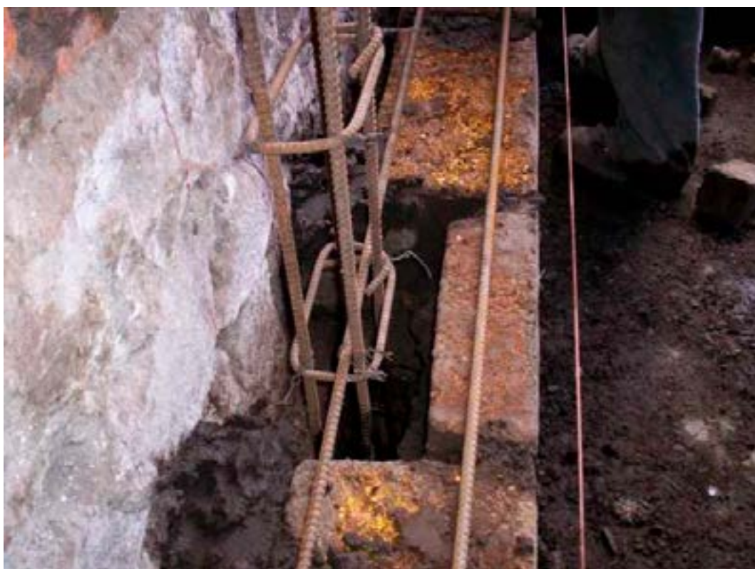
Foto 62. Armadura de hierro dentro de muro de adobe. Foto M. Hidrobo, 2005
