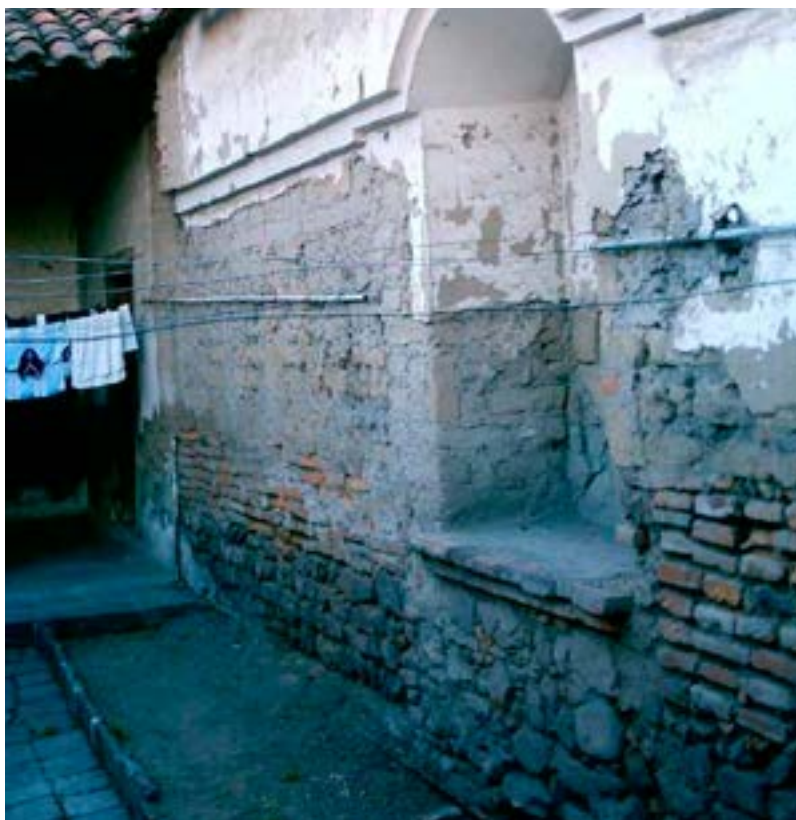
Foto 26. Vista muro entre patio 4 y 6. Foto M. Hidrobo, 2003
