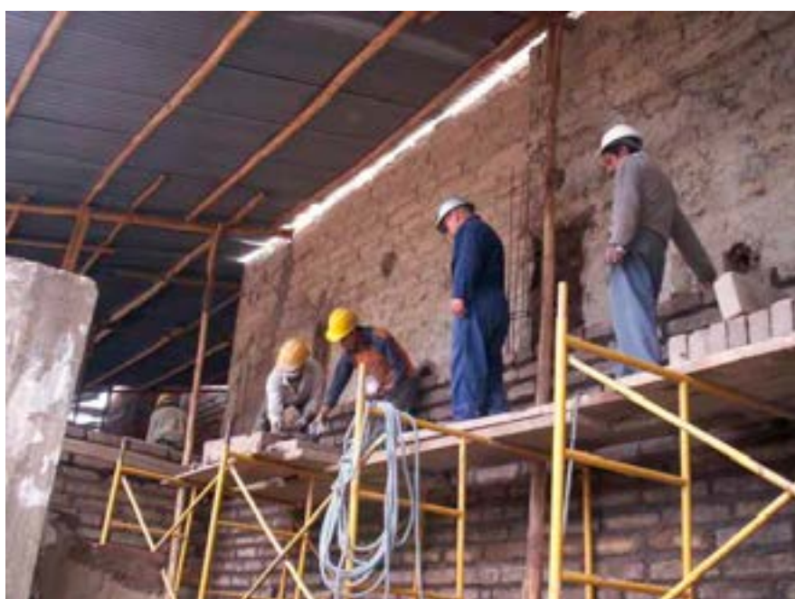
Foto 60. Muros levantados con refuerzos de hormigón armado. Foto M. Hidrobo, 2005
