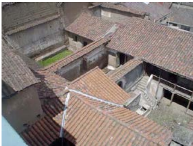
Foto 3. Vista superior: cubiertas y patios. Foto M. Hidrobo, 2003
