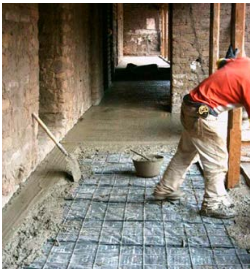
Foto 64. Fundición de loseta en galerías en patio 1. Foto M. Hidrobo, 2005
