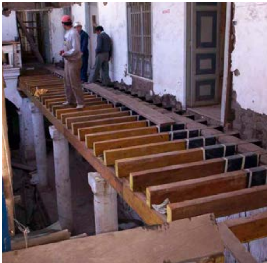
Foto 72. Vista superior de estructura nueva de cubiertas. Foto M. Hidrobo, 2003
