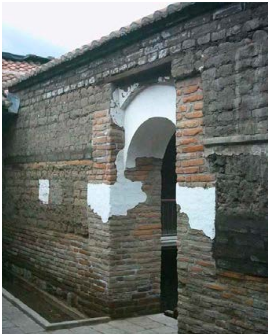
Foto 53. Vista de muro recuperado entre patio 4 y 2. Foto M. Hidrobo, 2006
