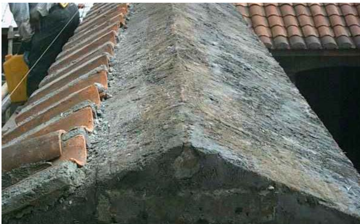
Foto 78. Colocación de teja. Foto M. Hidrobo, 2003
