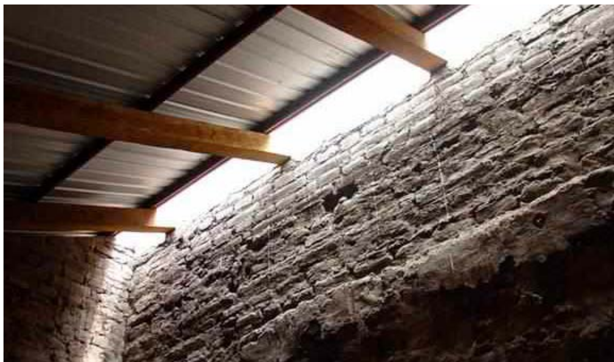
Foto 82. Vista interior de estructura de madera y detalle de claraboya en cubierta de un agua. Foto M. Hidrobo, 2006
