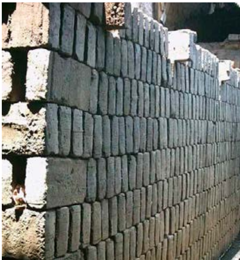
Foto 43. Secado de adobes al sol. Foto M. Hidrobo, 2005.
