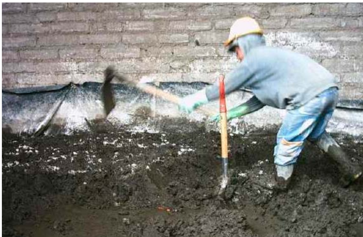
Foto 41. Preparación de la tierra para la fabricación de adobes. Foto M. Hidrobo, 2005.
