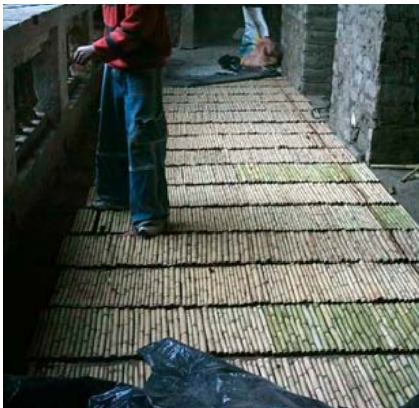
Foto 64. Fundición de loseta en galerías en patio 1. Foto M. Hidrobo, 2005
