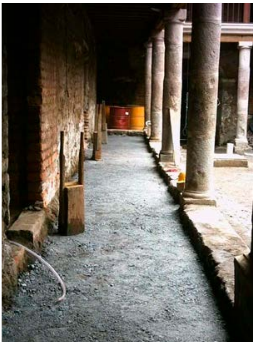
Foto 37. Contrapiso en galerías. Foto M. Hidrobo, 2005.
