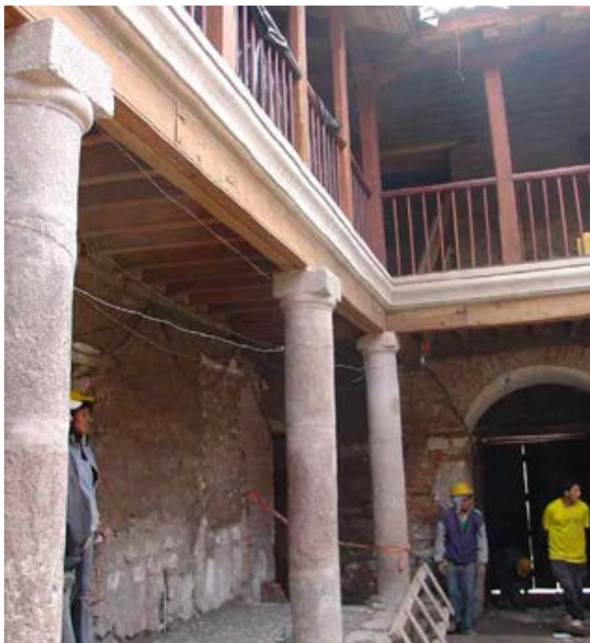
Foto 76. Vista de pilares y pasamanos de galerías, madera nueva. Foto M. Hidrobo, 2006
