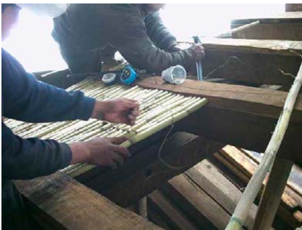
Foto 74. Amarrado de carrizo entre vigas de cubierta. Foto M. Hidrobo, 2003
