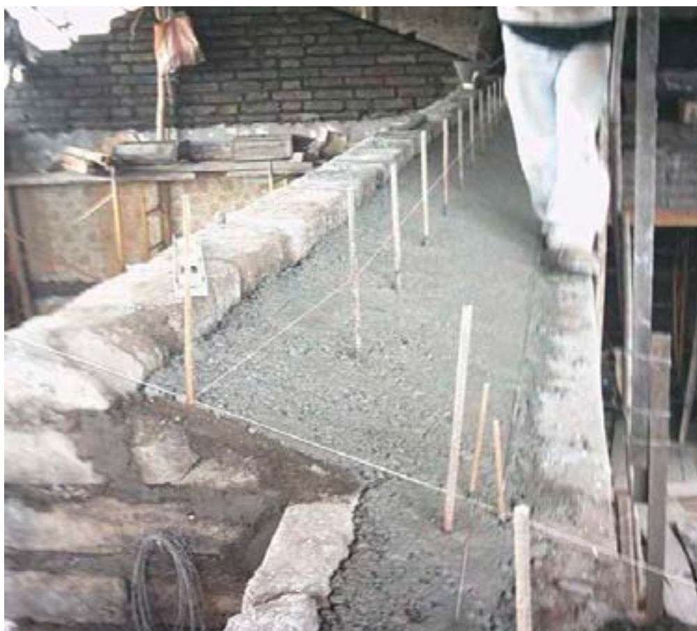
Foto 56. Cabeza de muro fundida con chicotes para recibir piezas de cubierta. Foto M. Hidrobo, 2005
