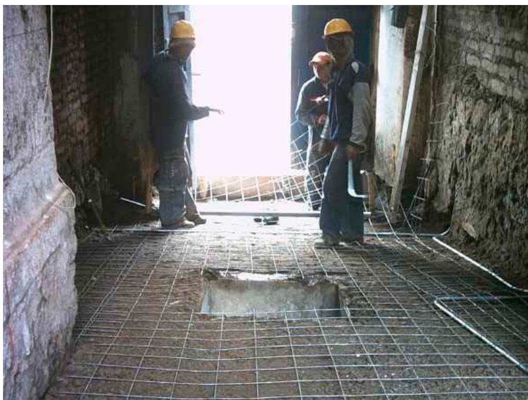
Foto 35. Preparación para fundir el contrapiso en zaguán. Foto M. Hidrobo, 2005.
