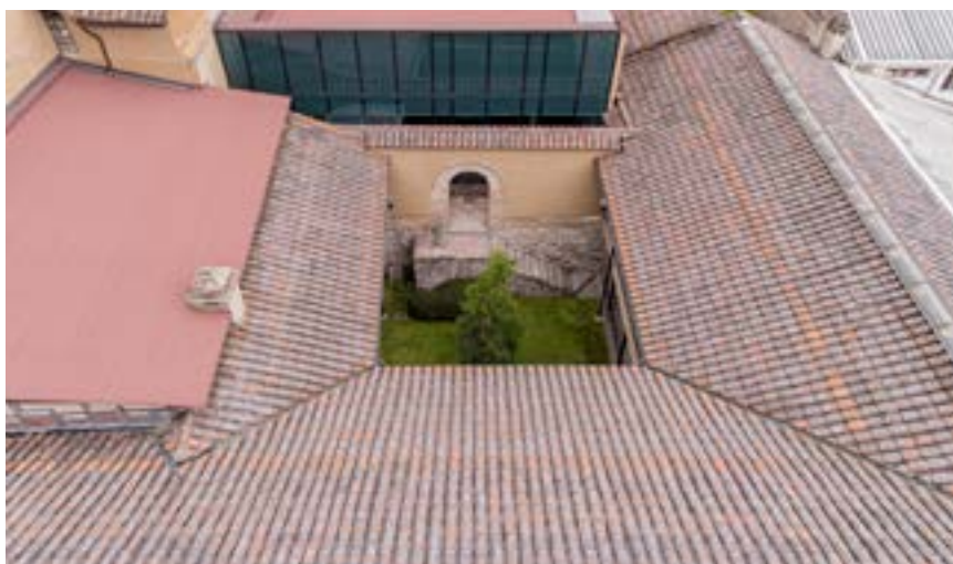
Foto 4. (Foto 7) Vista superior: cubiertas y patios. Foto S. de la Torre, 2021
