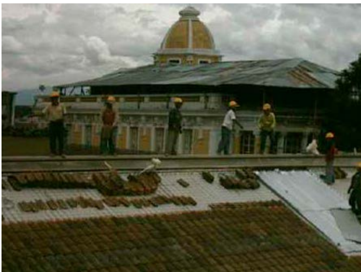
Foto 80. Colocación de teja sobre placas metálicas. Foto M. Hidrobo, 2003
