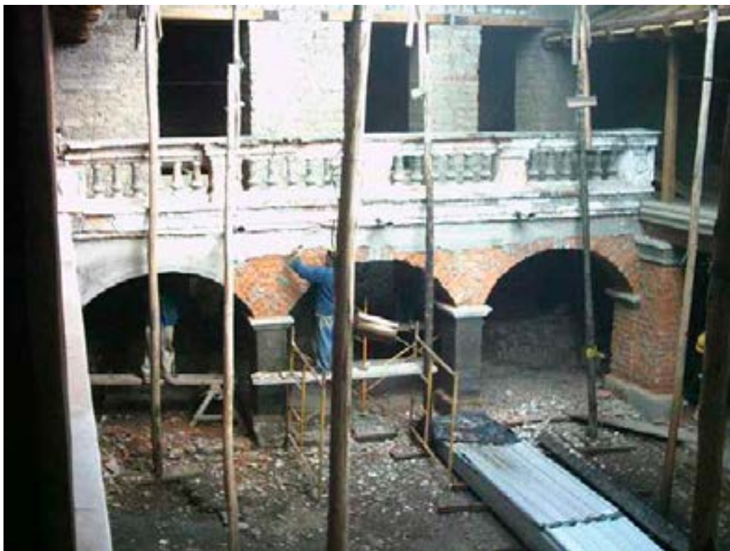
Foto 50. Colocación de gárgola nueva en base de balaustrada. Foto M. Hidrobo, 2005
