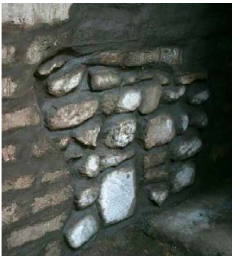
Foto 46. Calzado de piedra en "cimientó" encontrado en muro de adobe. Foto M. Hidrobo, 2005.
