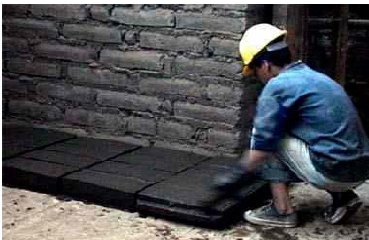
Foto 42. Fabricación de adobes in situ. Foto M. Hidrobo, 2005.
