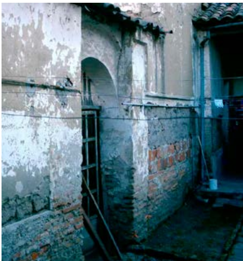
Foto 25. Vista muro entre patio 2 y 4. Foto M. Hidrobo, 2003
