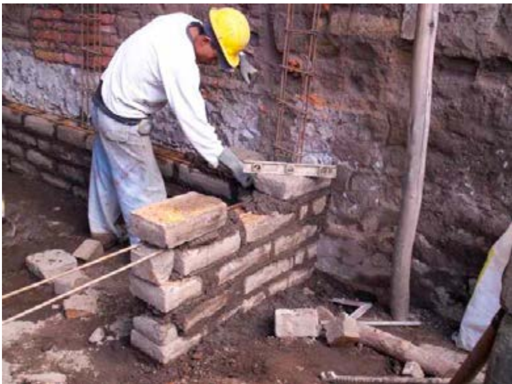
Foto 62. Armadura de hierro dentro de muro de adobe. Foto M. Hidrobo, 2005
