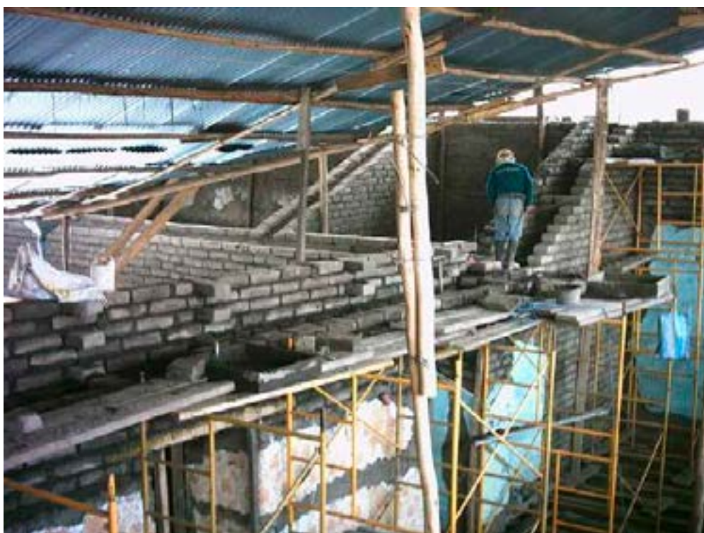
Foto 48. Muros que fueron levantados en su totalidad y muros rematados con adobe nuevo. Foto M. Hidrobo, 2005
