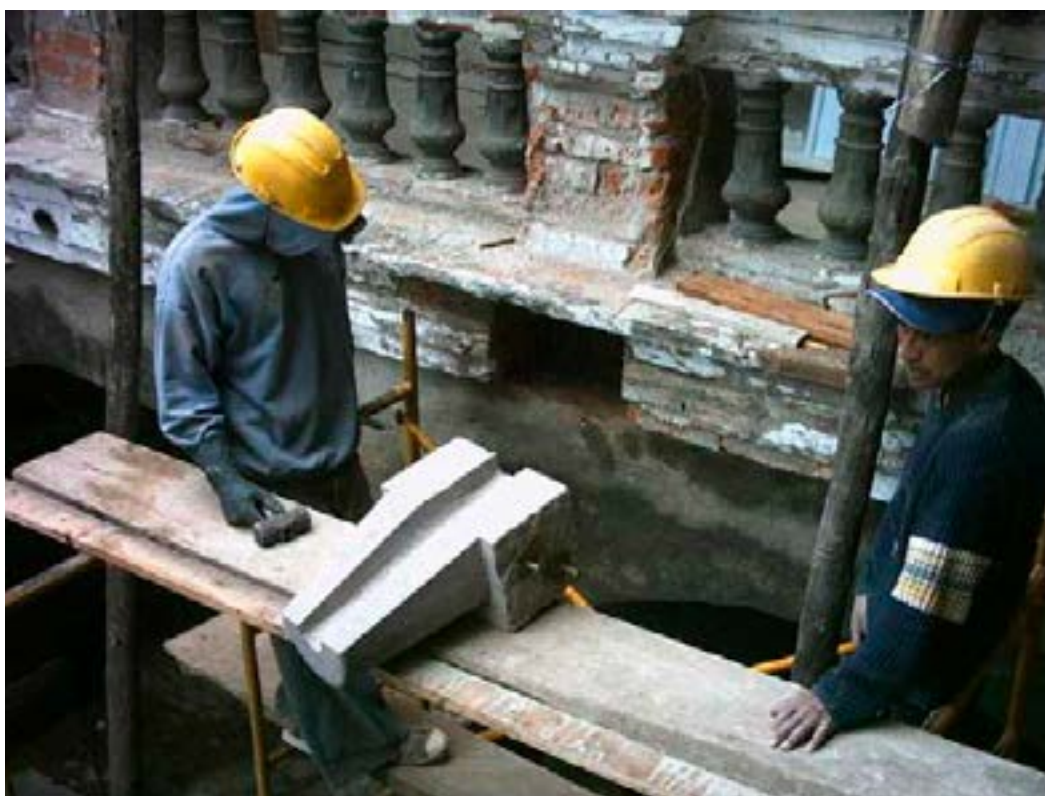
Foto 50. Colocación de gárgola nueva en base de balaustrada. Foto M. Hidrobo, 2005
