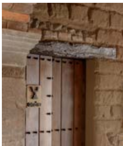
Foto 8. (Foto 34) Detalle de dintel de madera en zaguán de ingreso. Foto S. de la Torre, 2021
