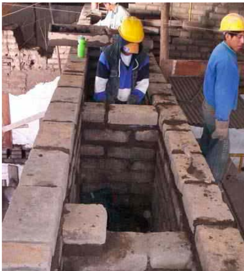
Foto 47. El armado de los muros huecos, (muro alveolar) permitió alivianar la estructura. Foto M. Hidrobo, 2005
