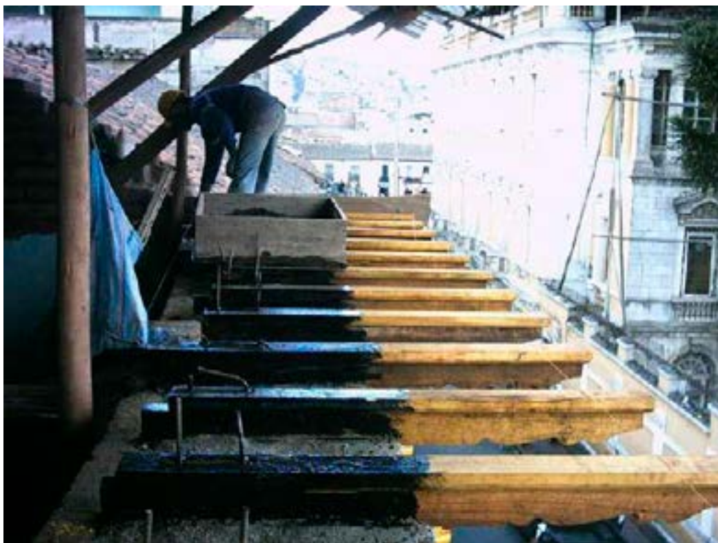
Foto 73. Colocación de canchillos en alero de fachada. Foto M. Hidrobo, 2003
