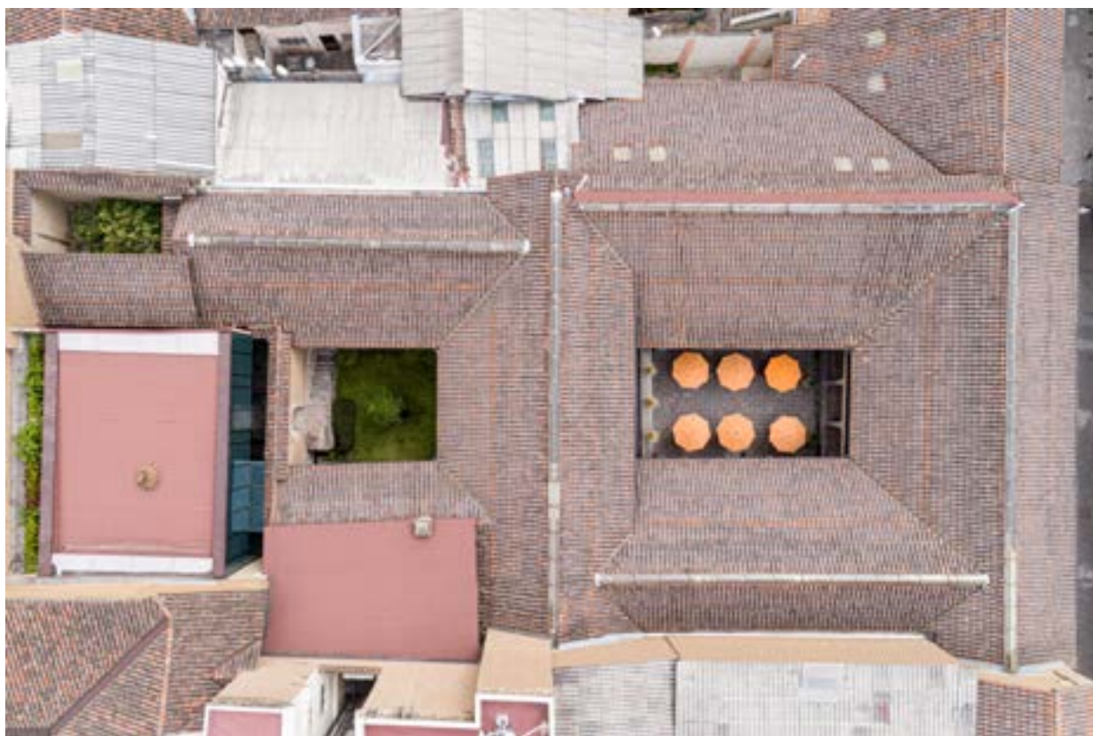
Foto 114. Vista aérea del Museo y sus patios. Se puede ver el detalle de tragaluces a lo largo de los cumbreros de cubierta. Foto S. de la Torre, Quito 2021
