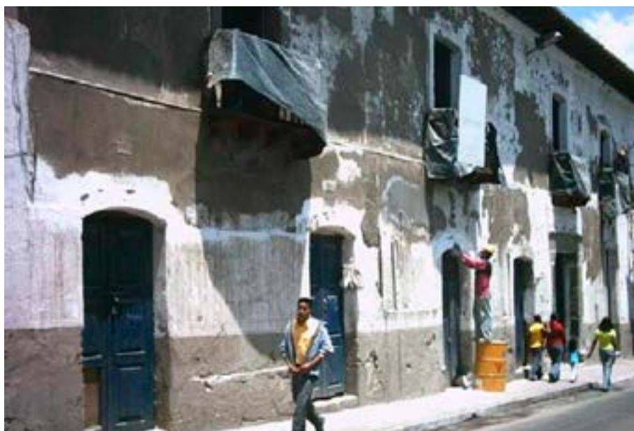
Foto 54. Trabajos de recuperación en fachada. Foto M. Hidrobo, 2005.
