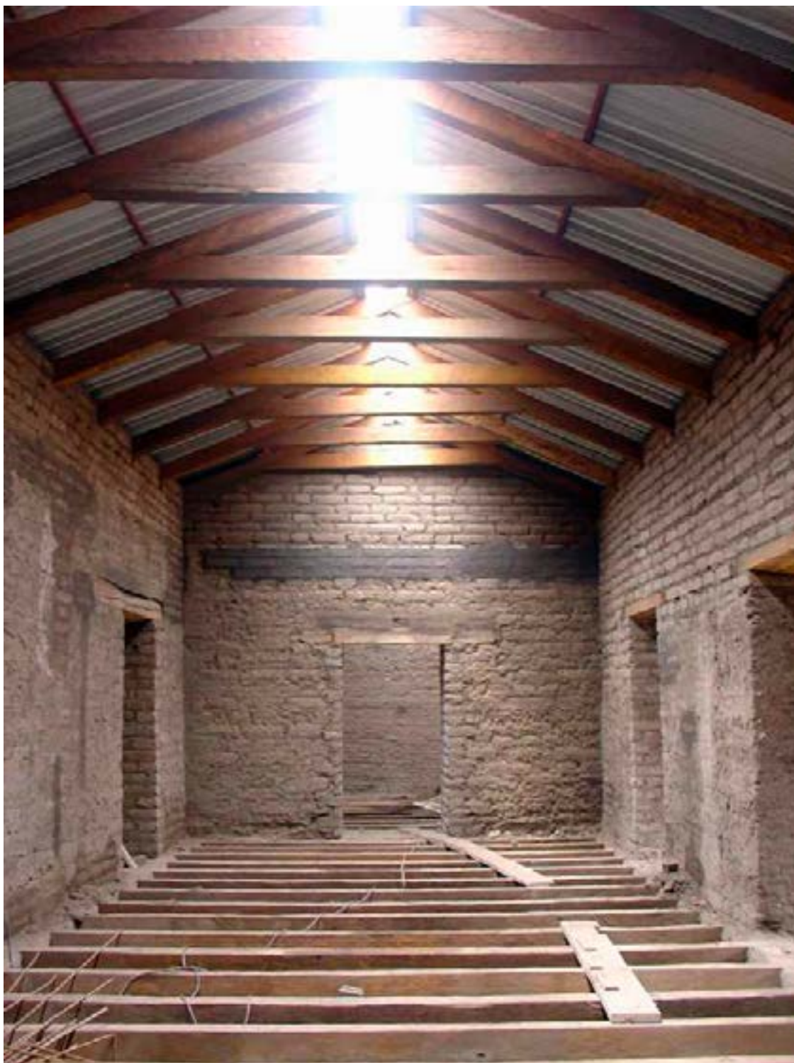
Foto 83. Vista de cerchas de par y nudillo y detalle de claraboya en cumbrero de cubiertas. Foto M. Hidrobo, 2006
