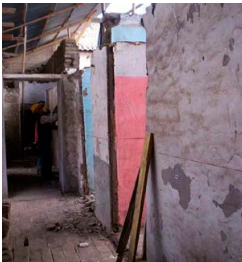
Foto 44. Vista de muros antes de pelar los enlucidos. Foto M. Hidrobo, 2005
