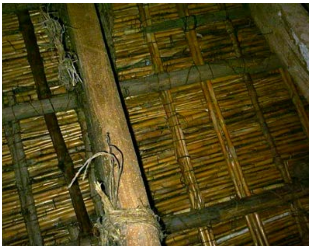
Foto 70. Carrizo y madera rolliza encontrada al interior de las cubiertas. Foto M. Hidrobo, 2005
