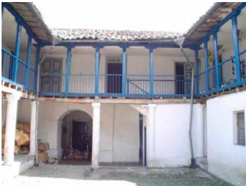
Foto 18. Vista hacia zaguán y crujía frontal, en patio 1. Foto M. Hidrobo, 2003
