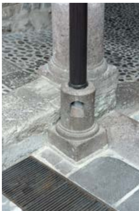
Foto 5. (Foto 33) Detalle de base de piedra para bajante, columna, bordillos, pisos en patio 1. Foto S. de la Torre, 2021
