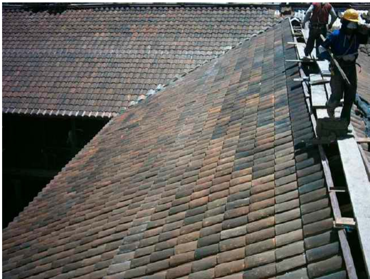
Foto 81. Vista de cubierta de teja por concluirse. Foto M. Hidrobo, 2003
