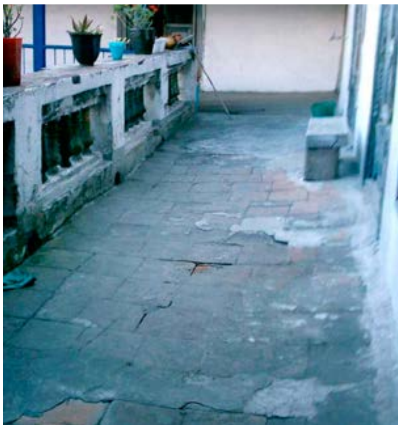
Foto 19. Vista de pavimento en terraza de crujía central. Foto M. Hidrobo, 2003
