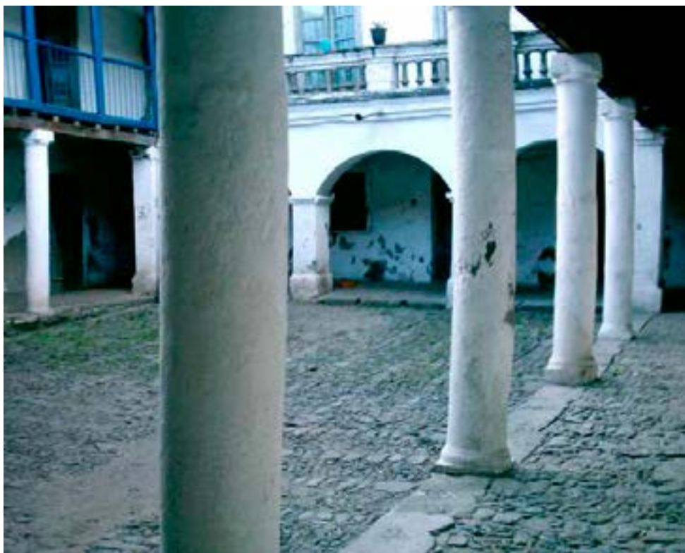
Foto 15. Vista del patio 1 y su galería. Foto M. Hidrobo, 2003
