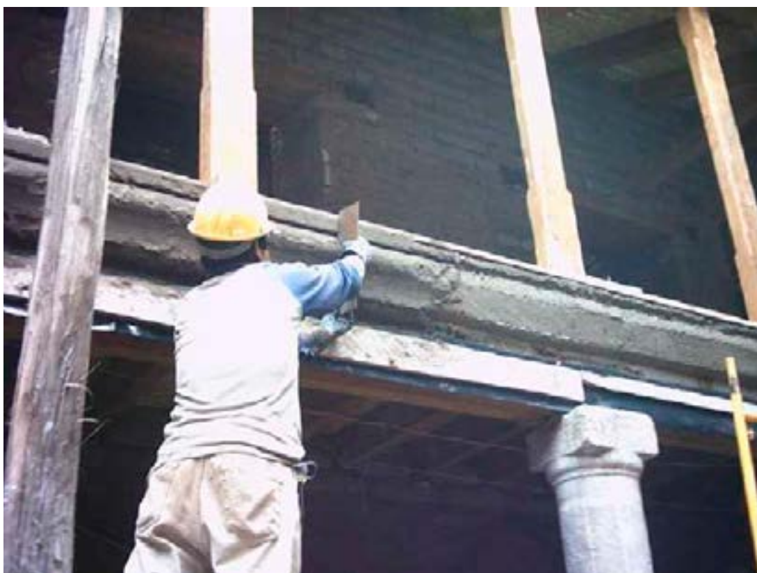
Foto 66. Ejecución de molduras de hormigón en galerías. Foto M. Hidrobo, 2005
