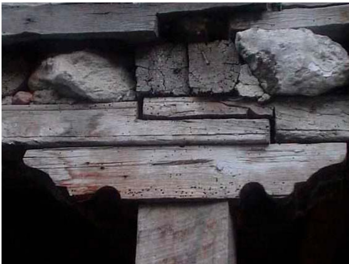
Foto 33. Piezas de piedra encontradas como apoyo improvisado. Foto M. Hidrobo, 2005.
