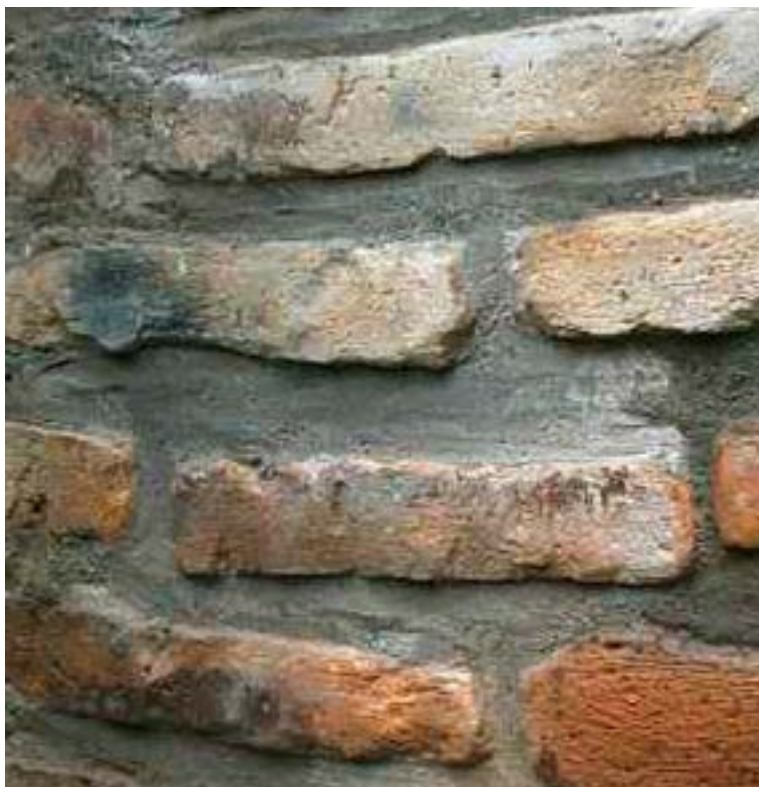
Foto 45. Calzado de muros de adobe con ladrillo. Foto M. Hidrobo, 2005.
