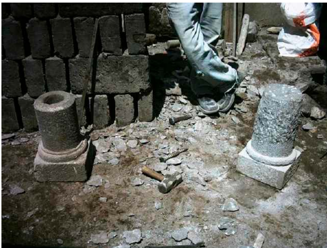
Foto 34. Tallado de bases nuevas según modelo existente. Foto M. Hidrobo, 2005.
