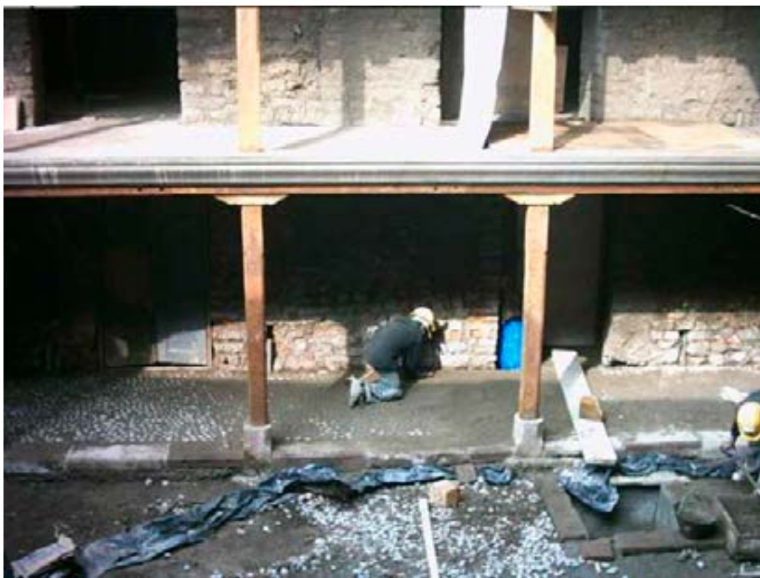
Foto 66. Ejecución de molduras de hormigón en galerías. Foto M. Hidrobo, 2005
