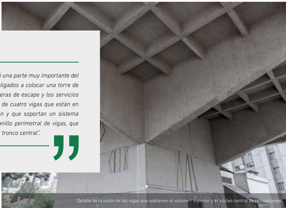
Detalle de la unión de las vigas que sostienen el volumen superior y el núcleo central de circulaciones.
