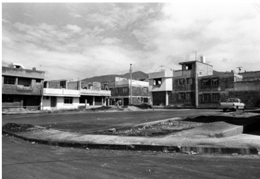
Solanda en construcción en 1988. Fotografía autor desconocido. Fuente: Archivo Diario El Comercio in Kueva, 2017.
