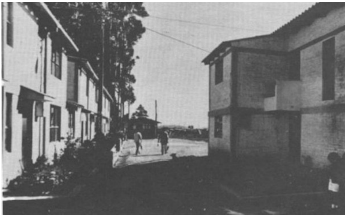
Fotografía exteriores viviendas construidas de la zona experimental, presentado en la I Bienal de Arquitectura de Quito, en 1978. Fuente: Archivo BAQ.
